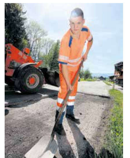
Justin Wagner (20) aus Kaltbach lernt Strassenbauer bei der Lötscher Tiefbau AG in Luzern. Foto apimedia
